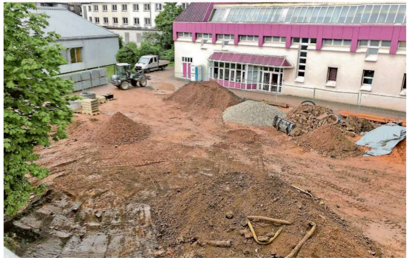
Der Sporthof am Mannlich-Gymnasium ist noch Baustelle. Ist man hier fertig, dann ist das Großbauprojekt beendet. FOTO: ULRIKE STUMM
